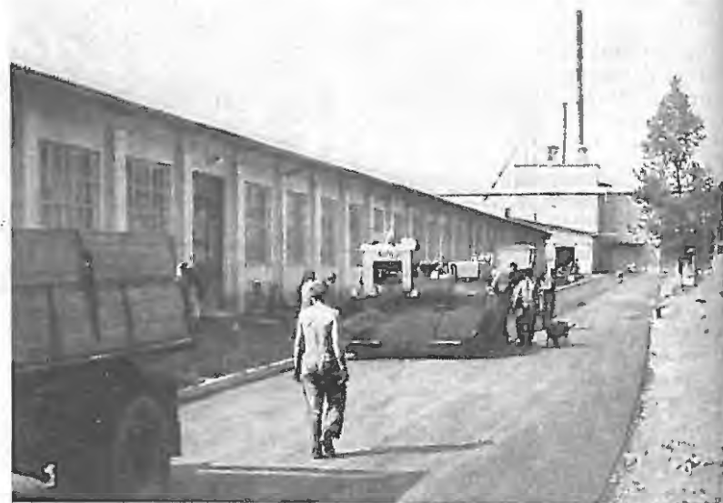
Asfaltiranje poti okrog TP Cerknica
