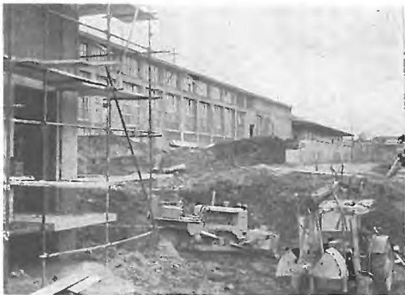
Gradnja transformatorske postaje v TP Martinjak
