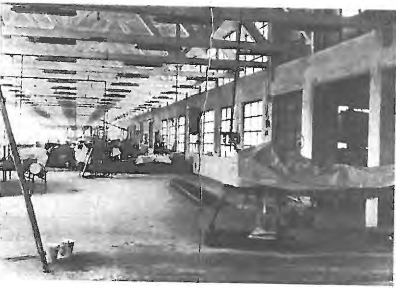
Rekonstrukcija montažne dvorane v TPC
