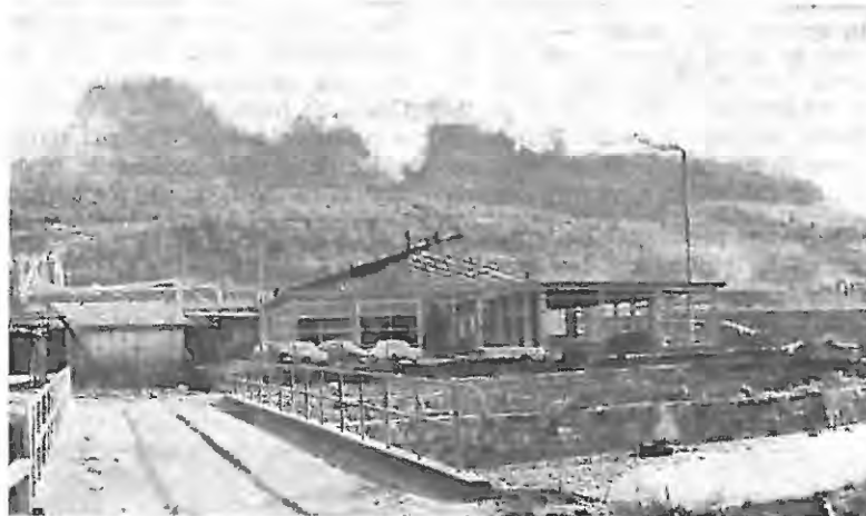
Skladišče pri Iverki še v času gradnje
