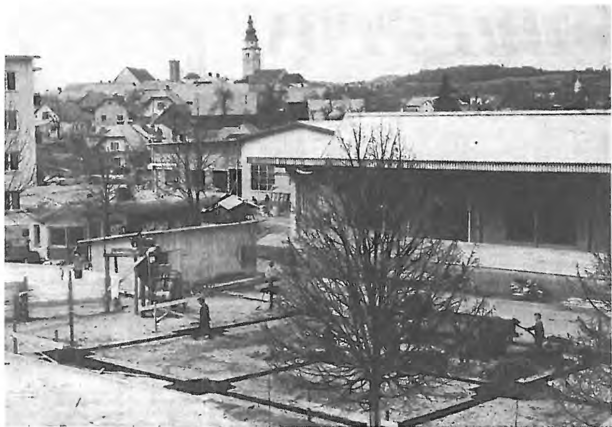
Pogled na gradbišče bodoče trgovine pohištva v Cerklji
