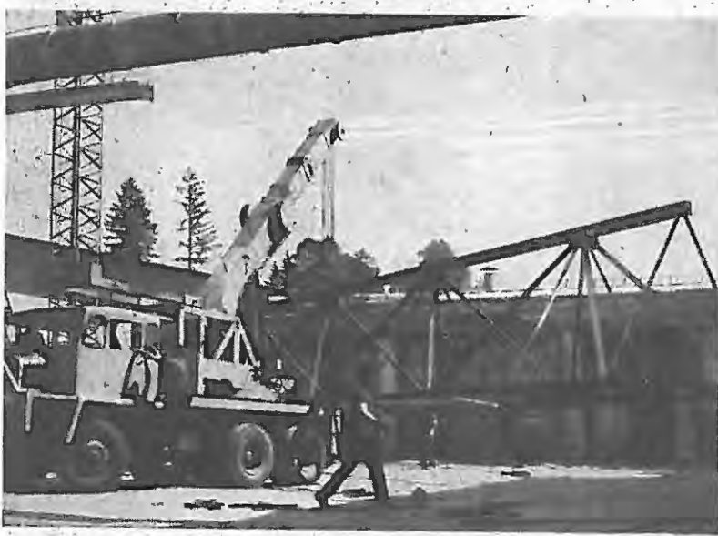
Z montažnimi elementi hitra in kvalitetna gradnja
