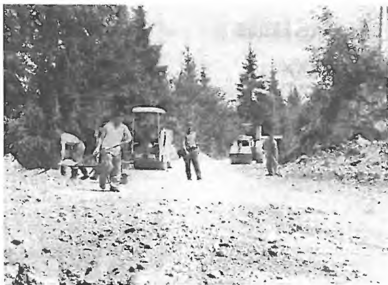
Asfaltiranje ceste med Bloško polico in Ložem
