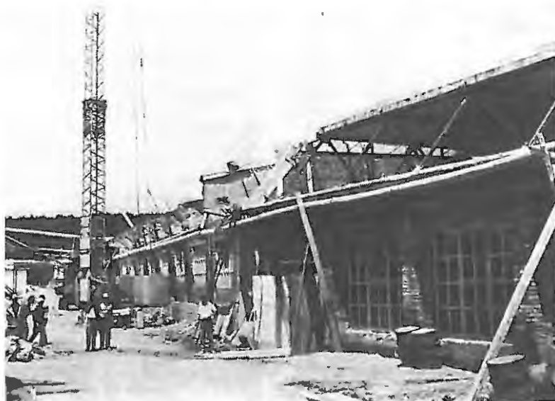
Na sliki je ogrodje novega ostrešja nad novo klejarno v Tovarni pohištva Cerknica.
