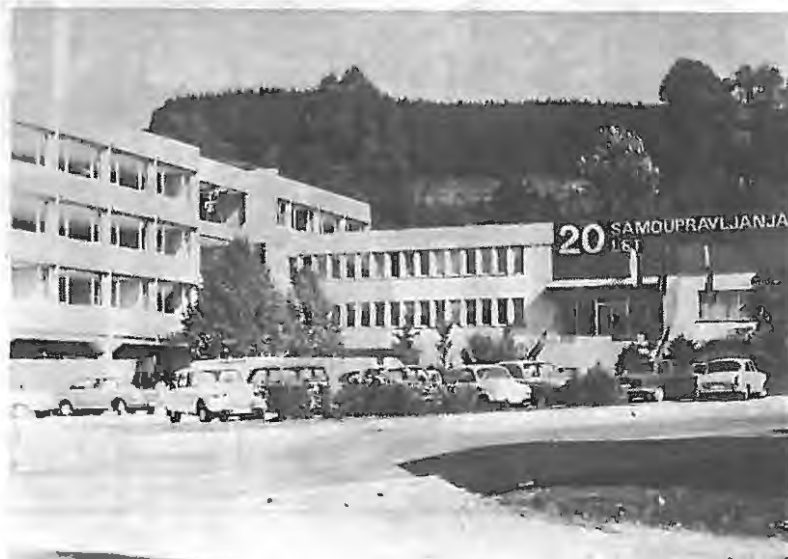
Pročelje zgradbe SKS ob praznovanju 20-letnice samoupravljanja Bresta
