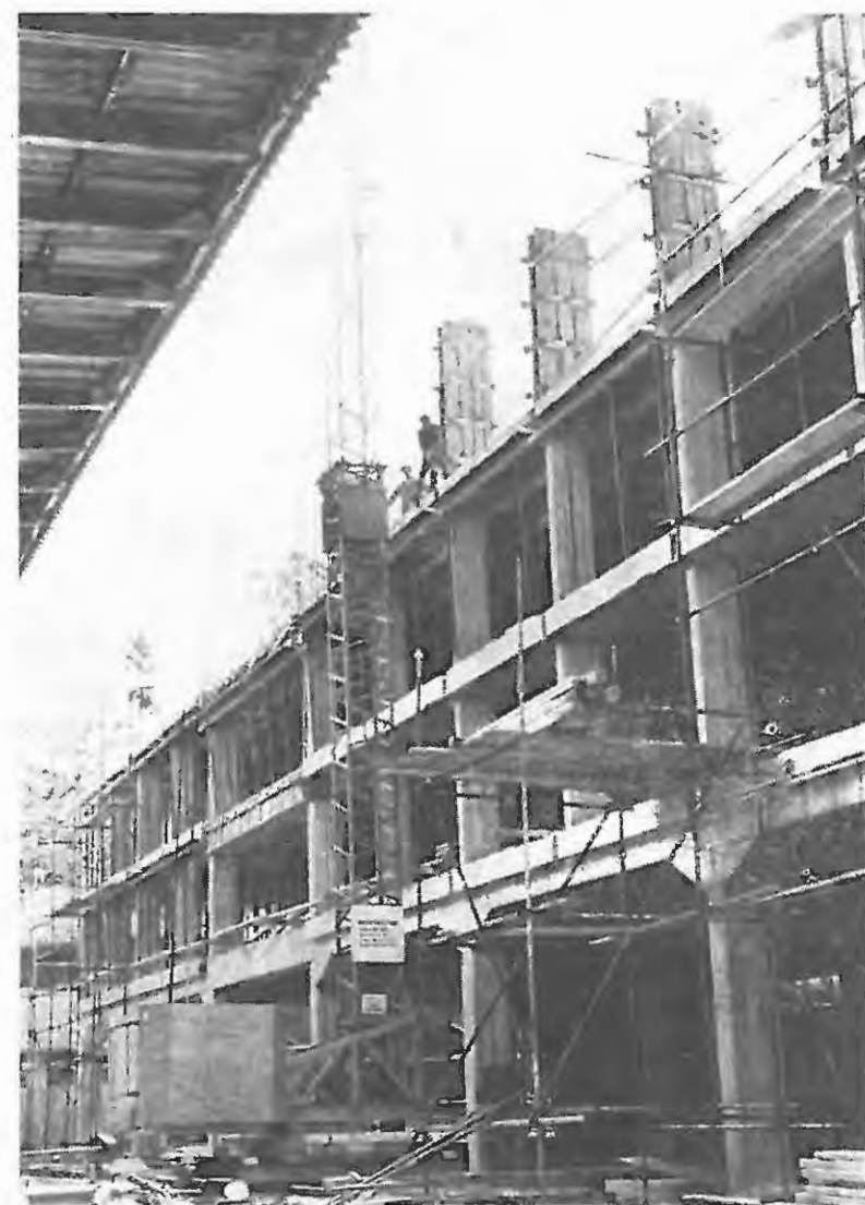
Delo pri gradnji prodajnih in poslovnih prostorov Bresta
