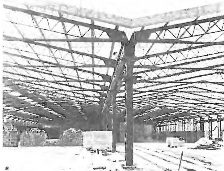
Skladišče gotovih izdelkov TP Cerknica v gradnji
