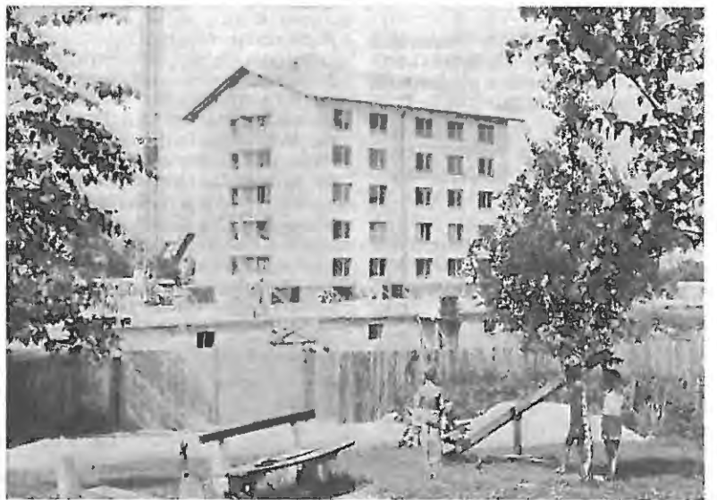
Gradnja tretjega stanovanjskega stolpiča v Vidmu
