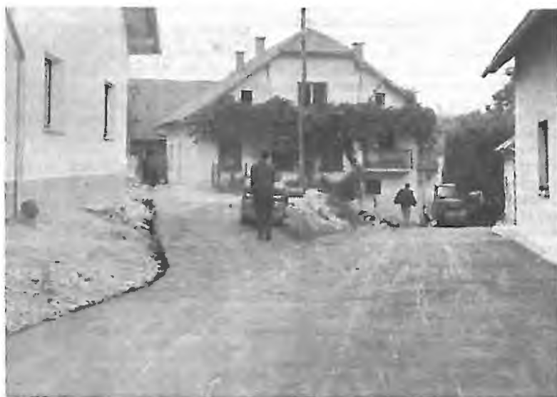
Zaključna asfaltna dela v Gerbičevi ulici
