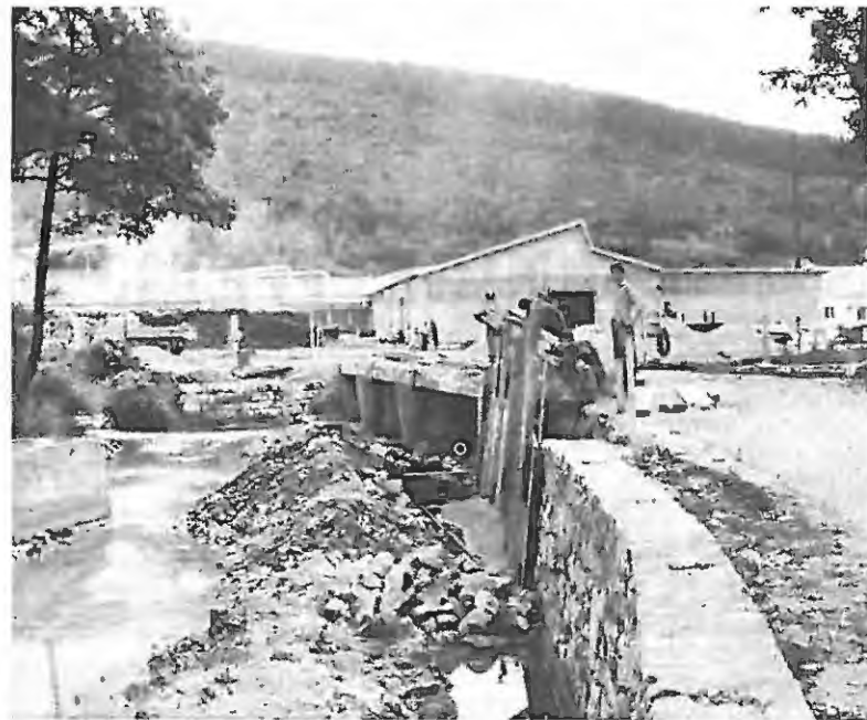
Gradnja opornega zidu ob Cerkniščici
