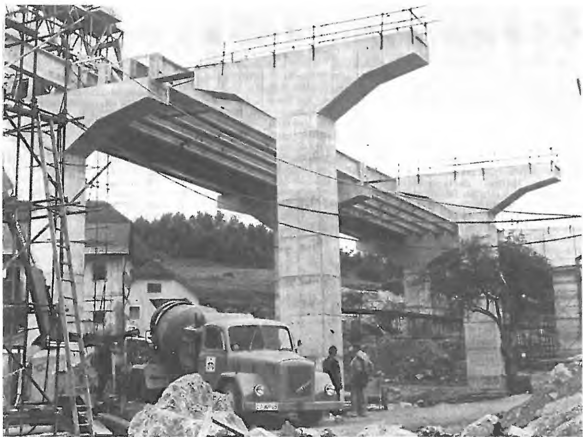
Dela na novi hitri cesti Vrhnika—Postojna naglo napredujejo. Pogled na železno-betonski skelet viadukta blizu »cerkniške deteljice« na Uncu
