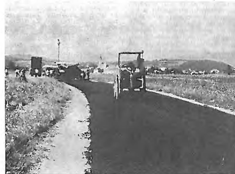
Zadnja dela na cesti proti Dolenjem jezeru
