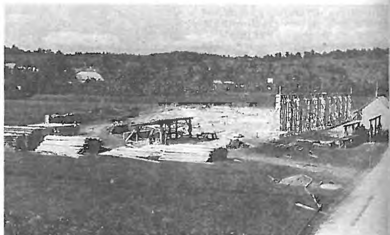
Temelji za Tovarno ivernih plošč v Cerknici
