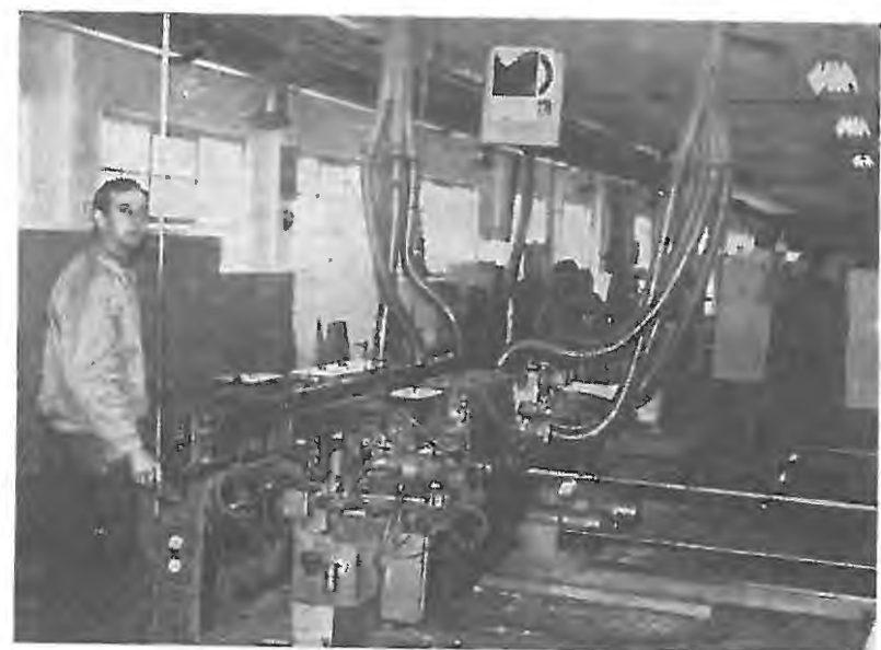
Naprava za robovno obdelavo v TP Stari trg
