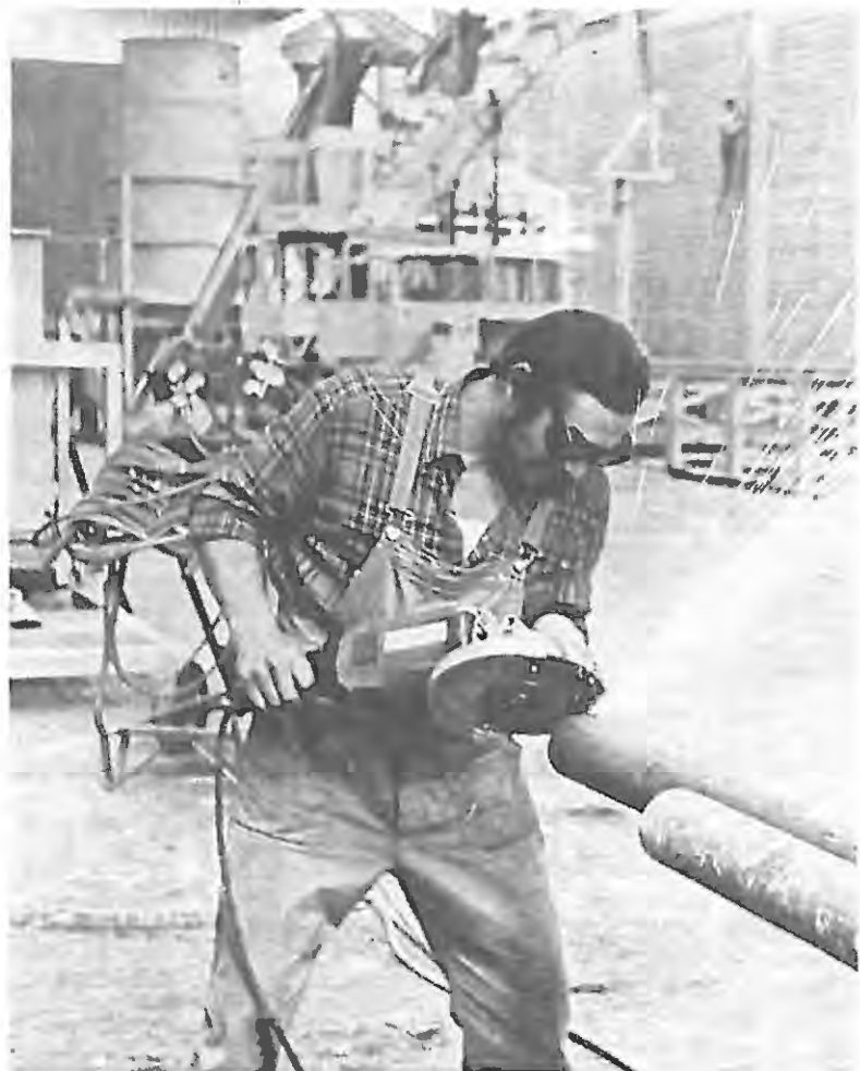
Montažna dela v novi tovarni ivernih plošč
