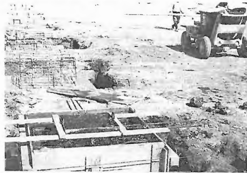
Z gradbišča v Podskrajniku — zrasli bodo proizvodni prostori nove temeljne organizacije
