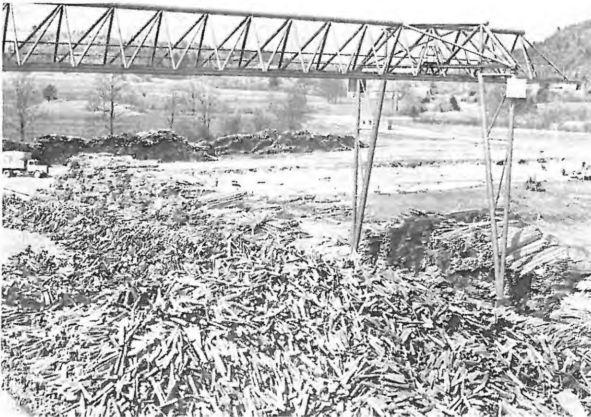
Skladišče nove tovarne ivernih plošč v Podskrajniku
