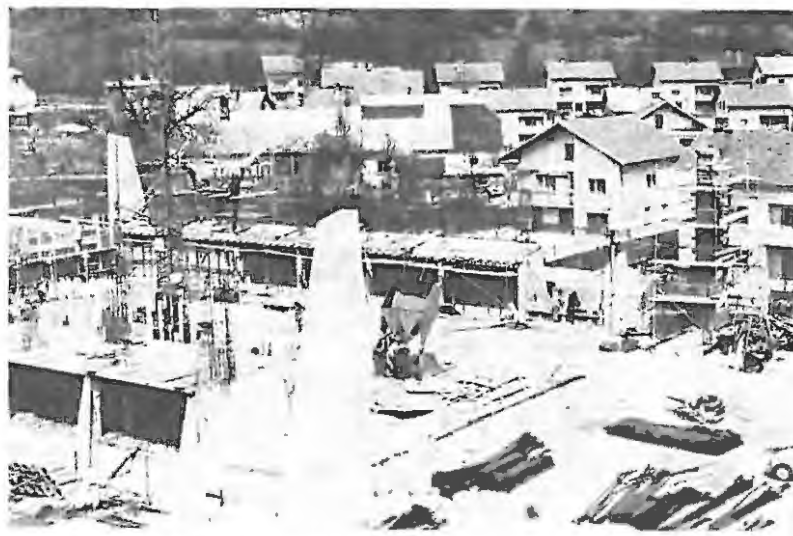
Gradnja nove telovadnice v Cerknici
