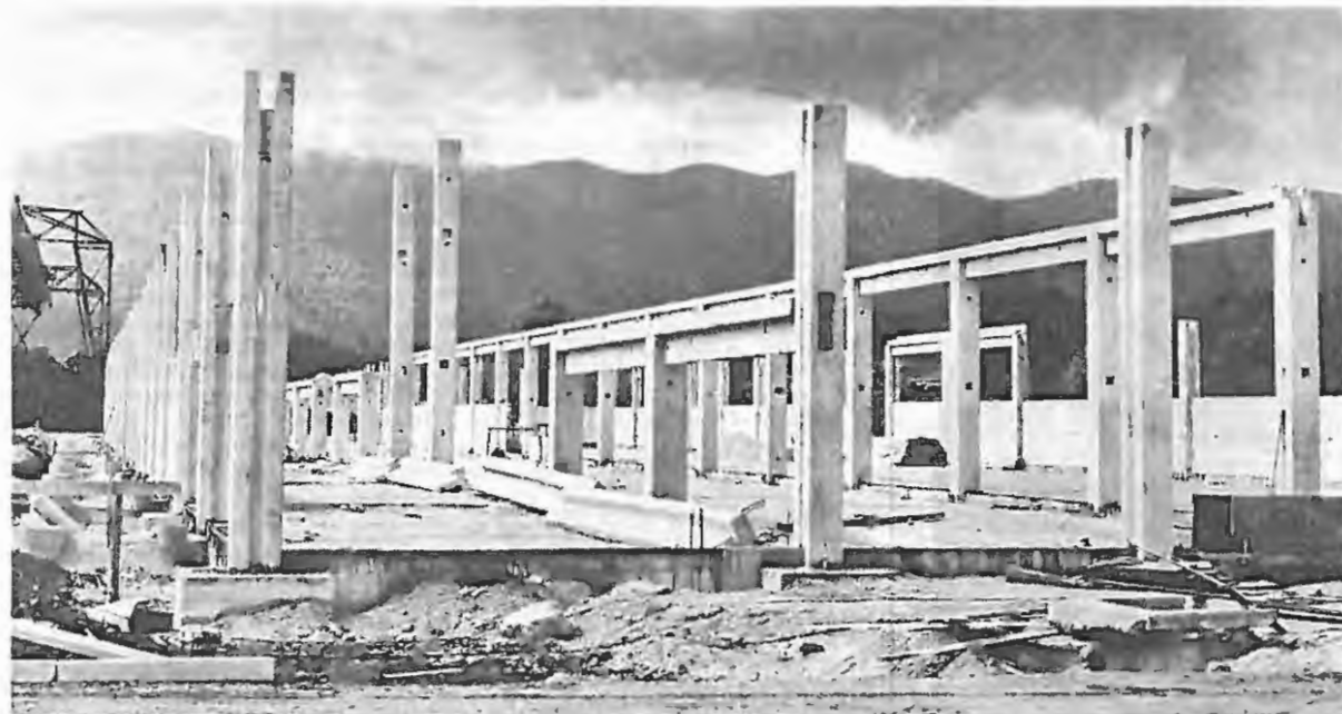
Z gradbišča novih proizvodnih prostorov za tapetništvo
