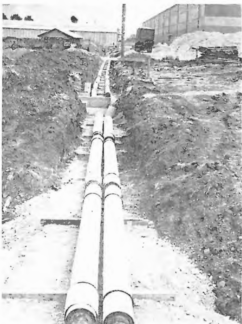
Toplovodne cevi za nove proizvodne prostore tapetništva
