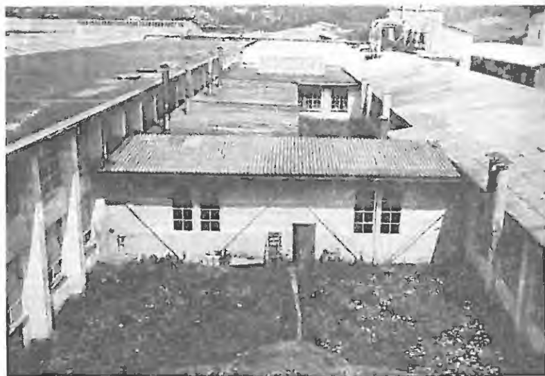
Tu bodo rekonstrukcijska dela v TP Cerknica
