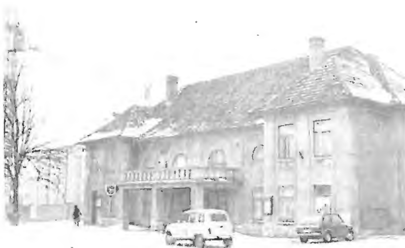
Kulturni dom v Cerknici je potreben obnove
