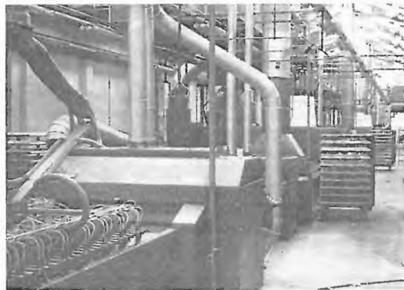
V okviru rekonstrukcije v TOZD POHIŠTVO se je pričelo poskusno obratovanje v sušilnem kanalu
