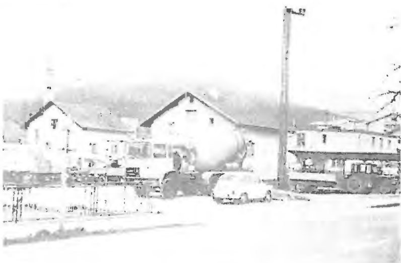
Splošno gradbeno podjetje GRADIŠČE že ob vhodu v Cerknico razstavlja svojo mehanizacijo. Naj vsi vidijo, kako smo moderni...
