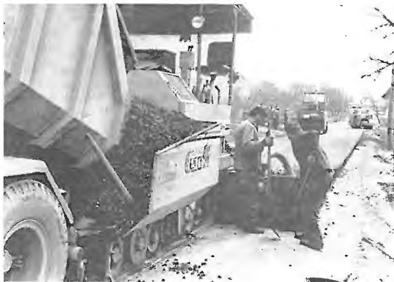
Ob praznikih bo odprta asfaltirana cesta Cajnarje—Selšček
