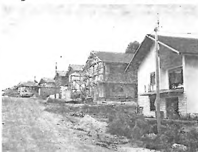
Gradbišče na Svinji gorici v Cerknici
