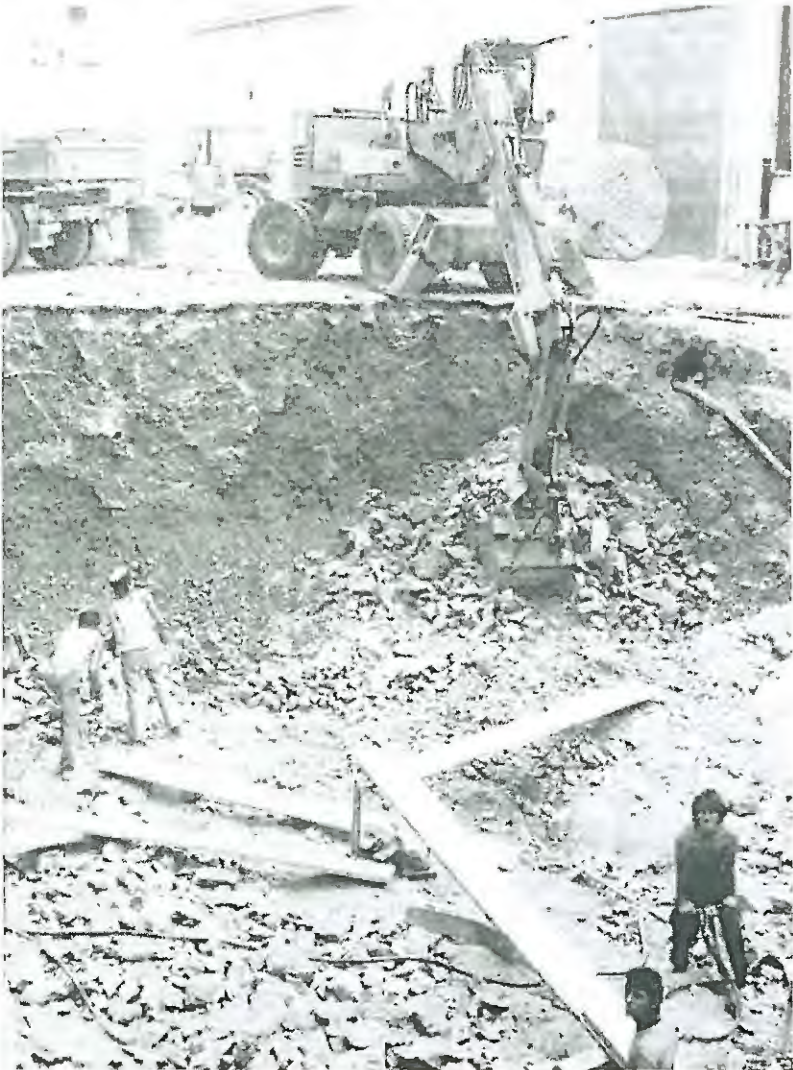
Gradnja tovarne mineralnih plošč — po načrtih
