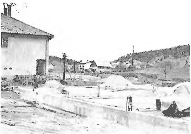
Temelji za novo šolo v Novi vasi
