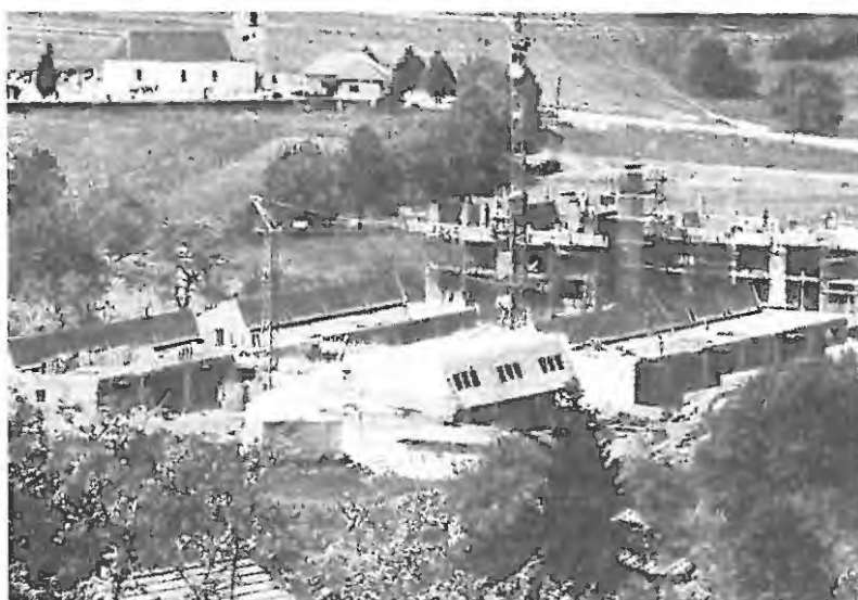
Gradbišče otroškega vrtca v Cerknici
