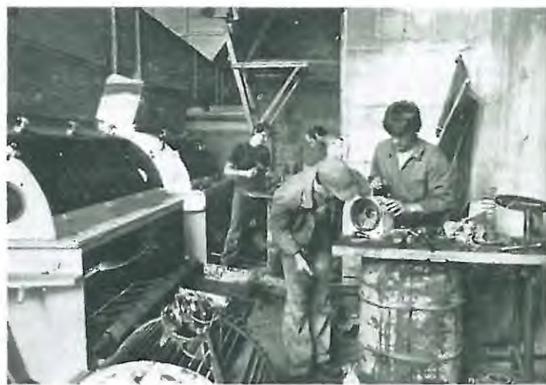
Dela pri remontu na naši Iverki
