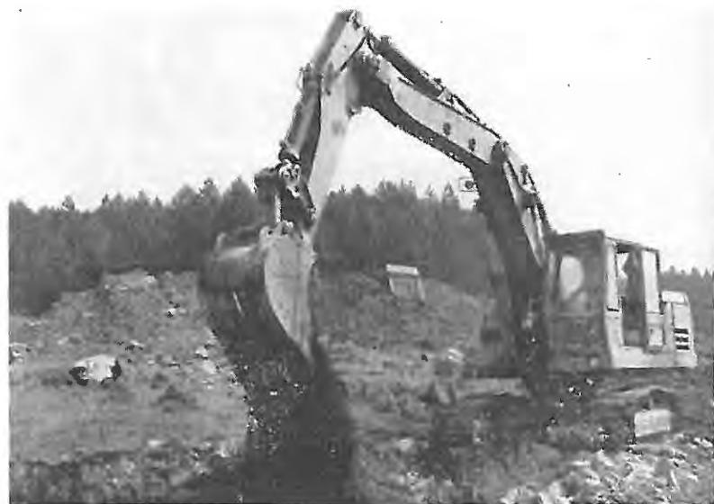
Gradnja rezervoarja za cerkniški vodovod
