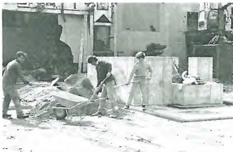
Dela pred montažo novega iverača na IVERKI
