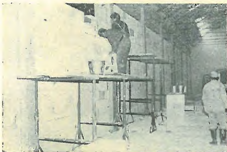
Priprava prostorov v centralnem skladišču za strojegradnjo
