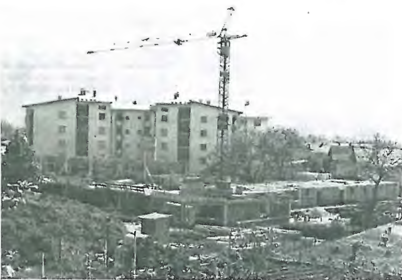
Gradbišče doma upokojencev v Cerknici
