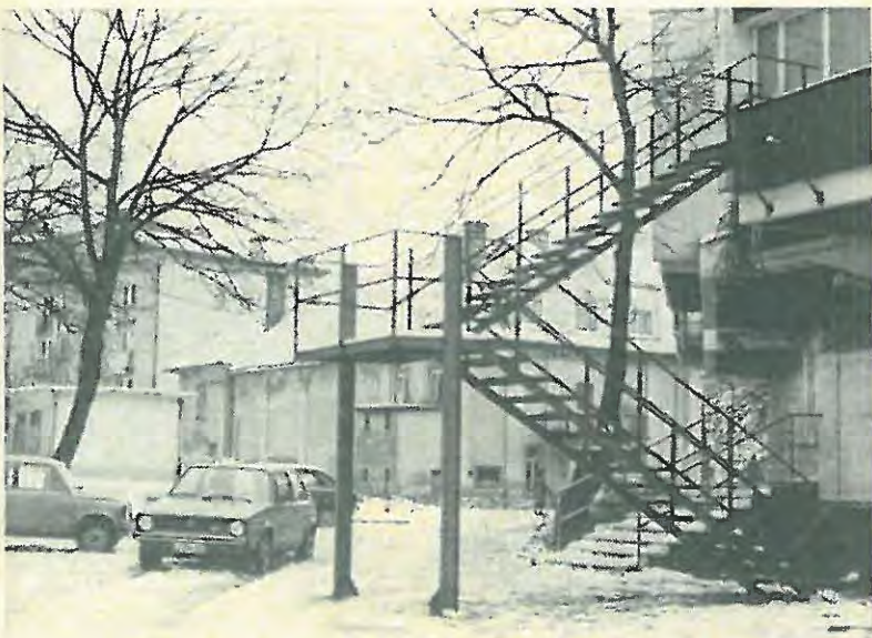
Drzna konstrukcija stopnišča pri blagovnici zavzame ves parkirni prostor. Menda je pripravljena nova rešitev.
