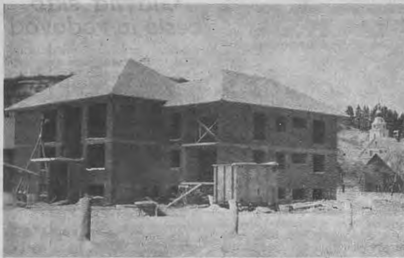
Zdravstveni dom v Starem trgu je že pod streho
