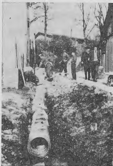
Polaganje vodovodnih cevi na Rakeku
